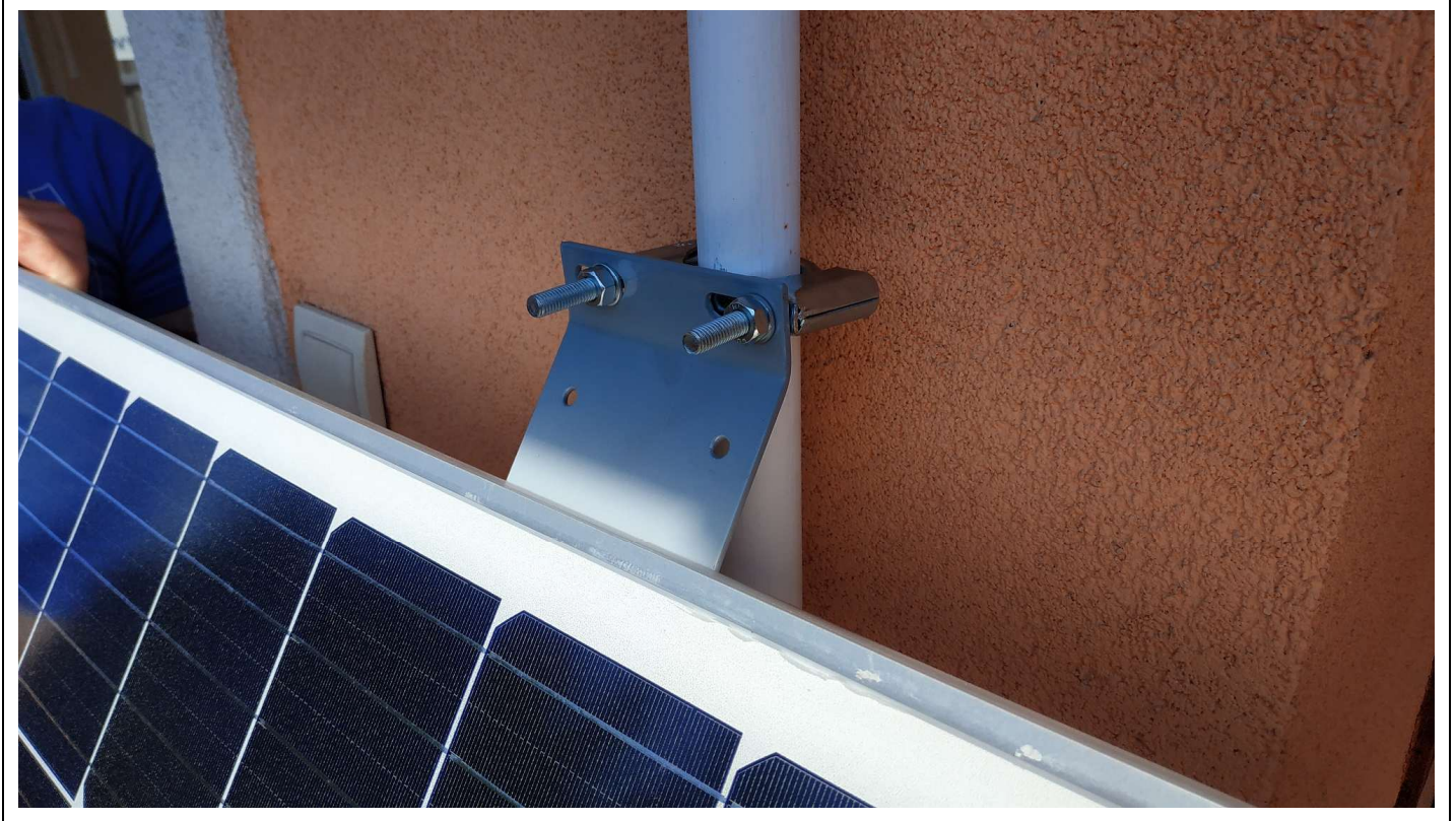
A napelem panel rögzíthető csőre a mellékelt bilincsek (2) segítségével.
